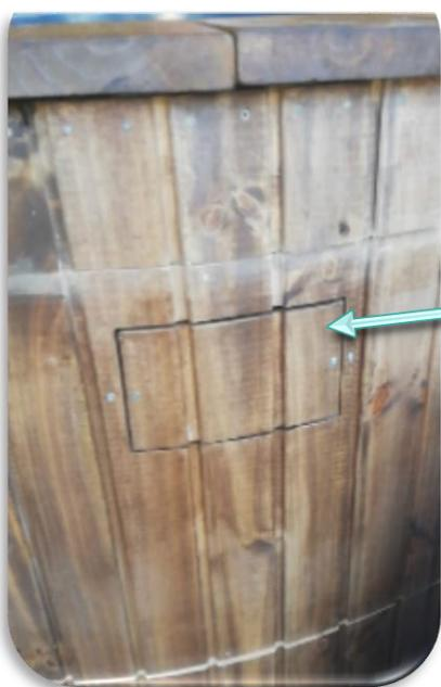
**Detrás de la tapa está el tablero. Se abre presionando y soltando de un costado. Tiene sistema de apertura y cierre PushUp.**
